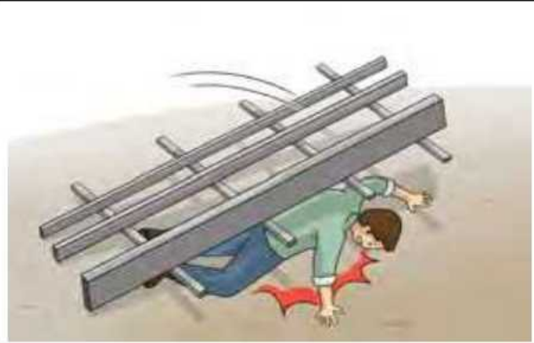
작업 중인 근로자가 철근구조물에 깔림
