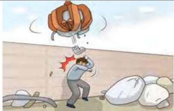
집게(너클) 크레인 작업 중 폐품이 떨어져 맞음
