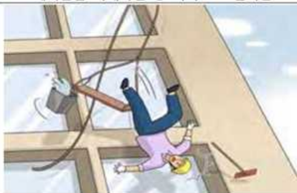
건물 외벽 청소 작업 중 달비계에서 떨어짐
