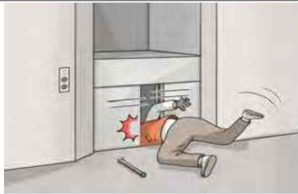
승강기 비전문가의 임의 수리·조작으로 불시 작동에 인한 끼임 및 떨어짐
